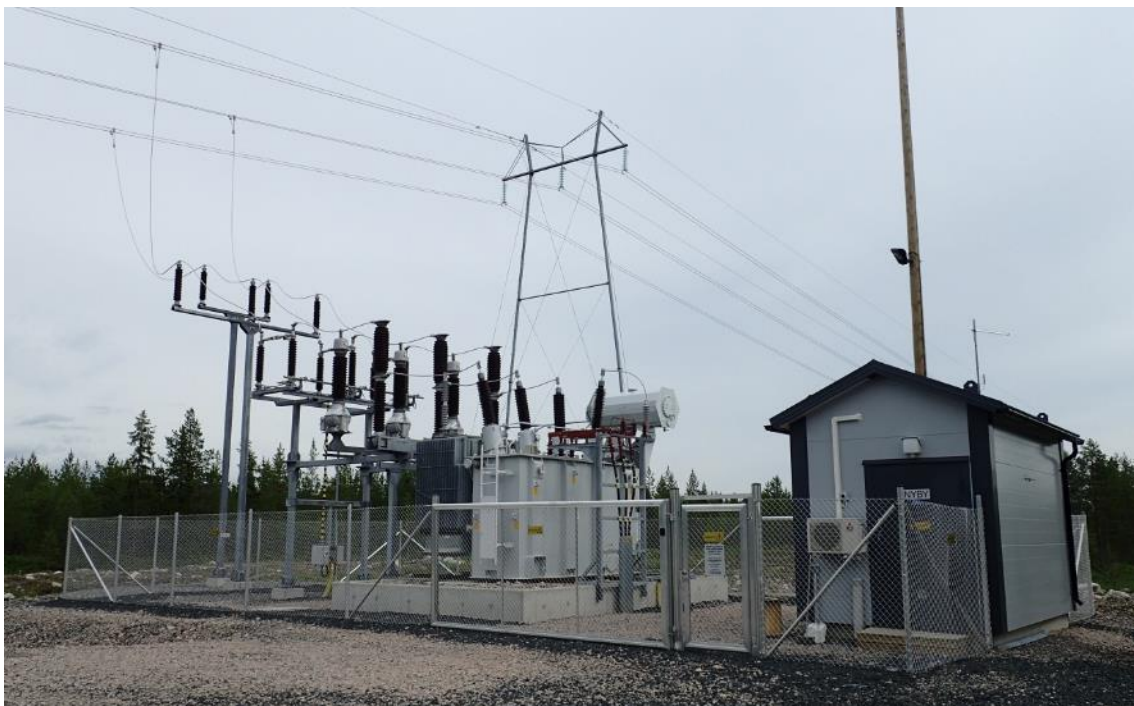
Kuva 81. Esimerkki tuulivoimapaiston sähkösemasta 110 kV (kuva Minna Takalo/FCG).
