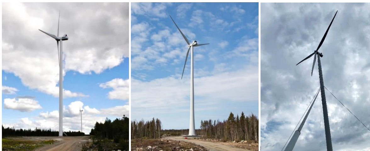
Kuva 74. Vasemmalla on esimerkki teräslieriötornista, keskellä hybriditornista ja oikealla harustetusta tornista. 250 metrin korkeuden ylittämisen ei välttämättä tarkoita harustettua tornia. (Kuvat: Leila Väyrynen ja Ville Suorsa, FCG sekä Jarkko Finnilä, Carelin.
