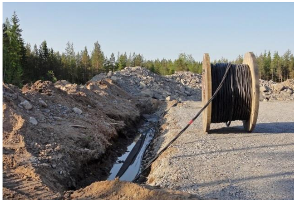
Kuva 83. Maakaapelit upotetaan huoltoteiden yhteyteen (kuvat: Ville Suorsa/FCG).
