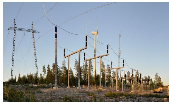
Kuva 87. Esimerkkikuvia tuulivoimapuiston 110/20 kV sähköasemasta. (Kuva: Leila Väyrynen/FCG).
