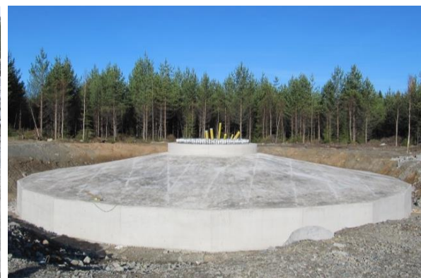
Kuva 84. Tuulivoimalan perustusten rakentamista. (Kuvat: Leila Väyrynen, FCG)
