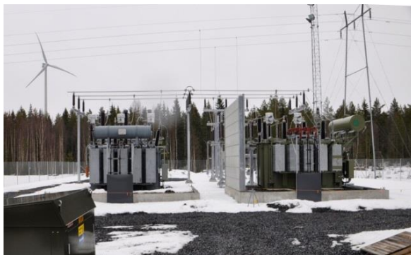
Kuva 87. Esimerkkikuvia tuulivoimapuiston 110/20 kV sähköasemasta. (Kuva: Leila Väyrynen/FCG).
