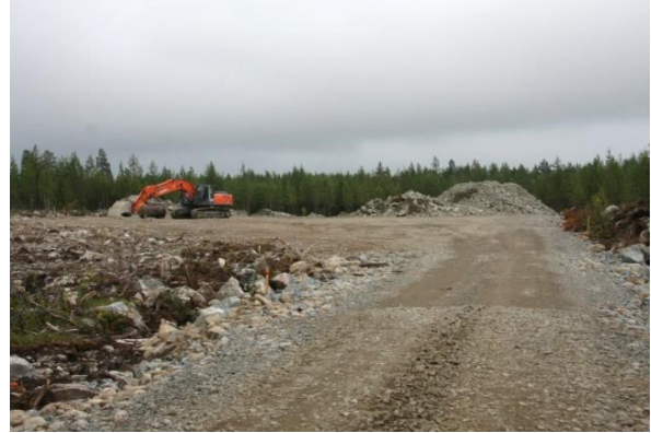
Kuva 82. Huoltoteiden ja pystytysalueiden rakentamista (kuvat: Ville Suorsa/FCG).
