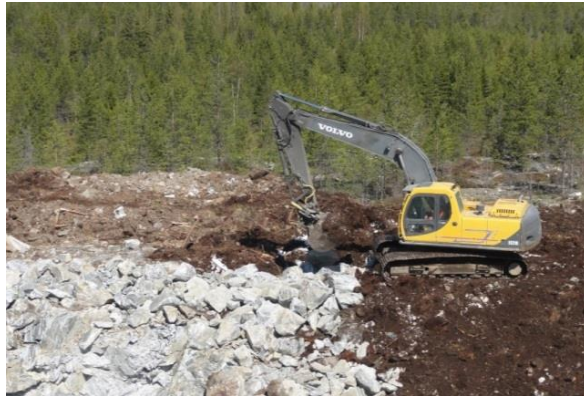
Kuva 82. Huoltoteiden ja pystytysalueiden rakentamista (kuvat: Ville Suorsa/FCG).
