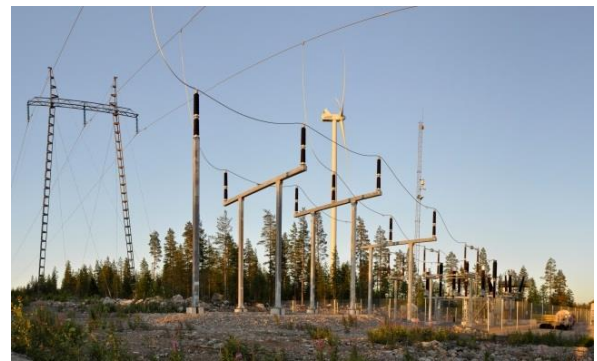
Kuva 87. Esimerkkikuvia tuulivoimapuiston 110/20 kV sähköasemasta. (Kuva: Leila Väyrynen/FCG).
