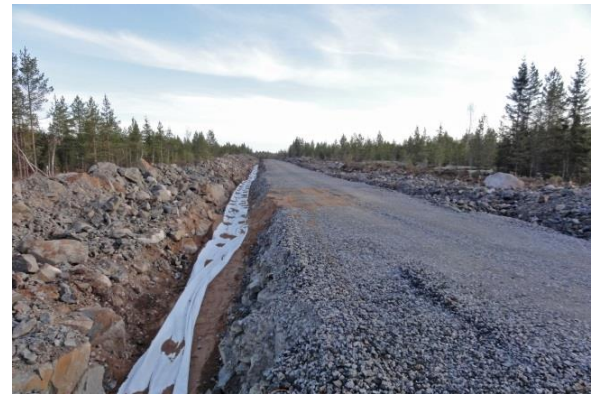
Kuva 83. Maakaapelit upotetaan huoltoteiden yhteyteen (kuvat: Ville Suorsa/FCG).
