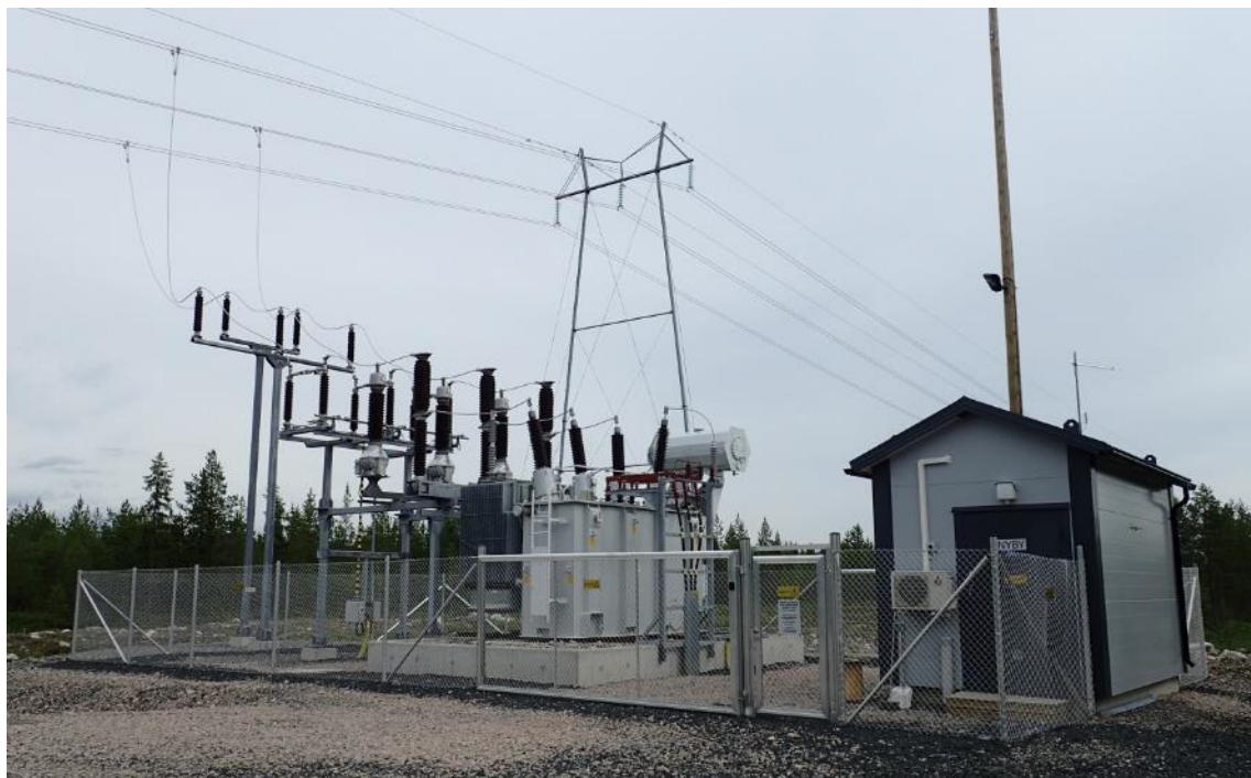
Kuva 81. Esimerkki tuulivoimapaiston sähkösemasta 110 kV (kuva Minna Takalo/FCG).
