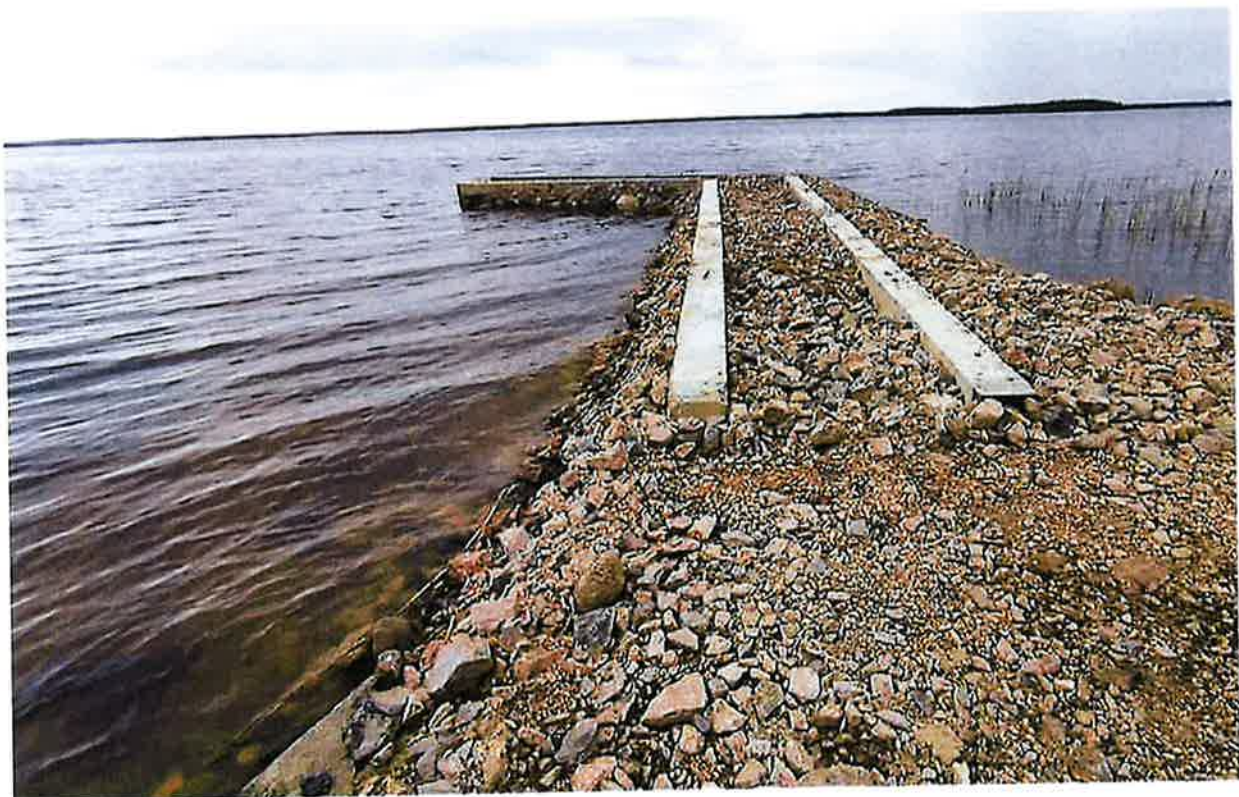
Kuva 1: Kivilaituri ja siihen asennetut betonipaalut
