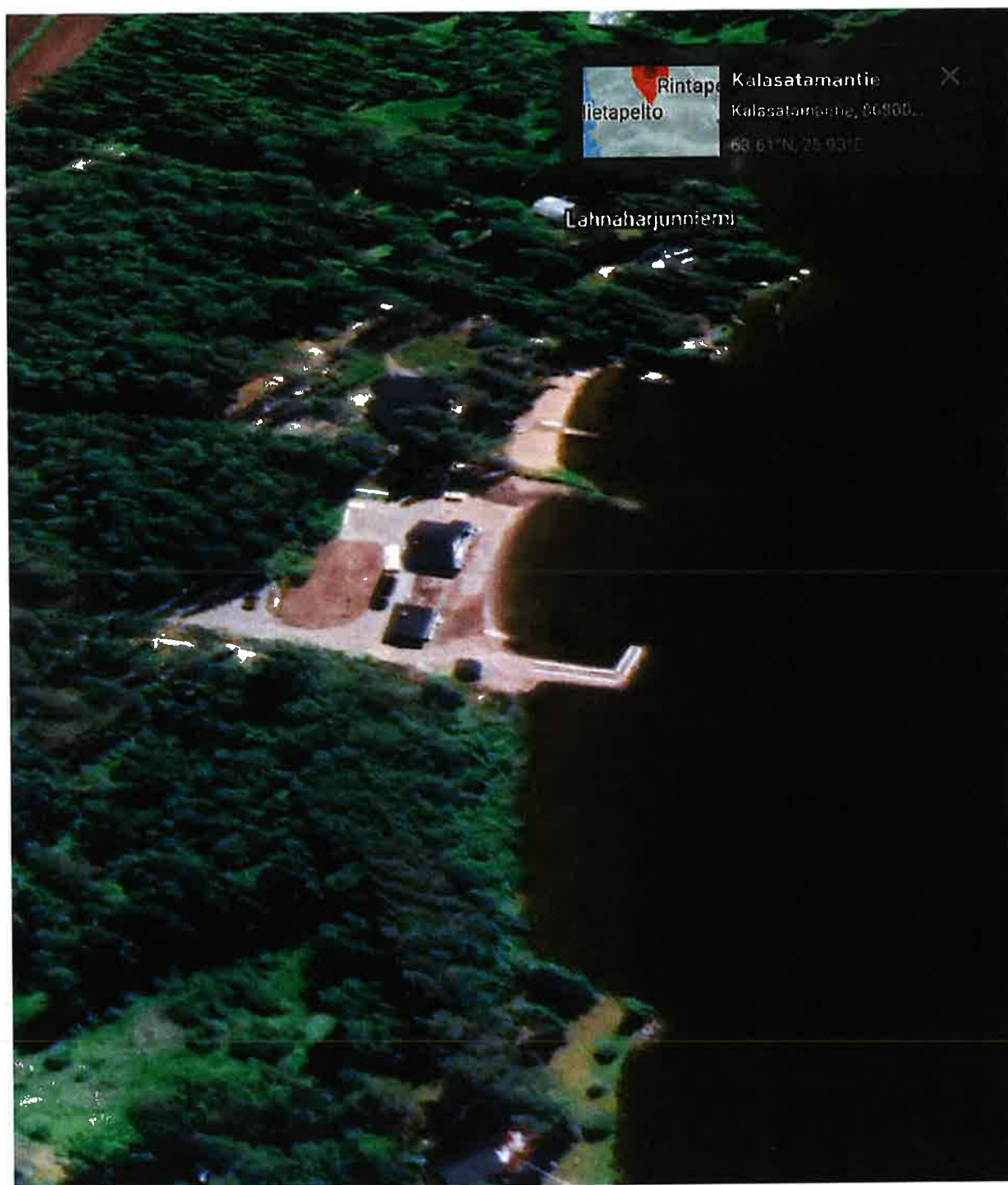
Kuva 5: Viistoilmakuva tilanteesta aallonmurtajan rakentamisen jälkeen
