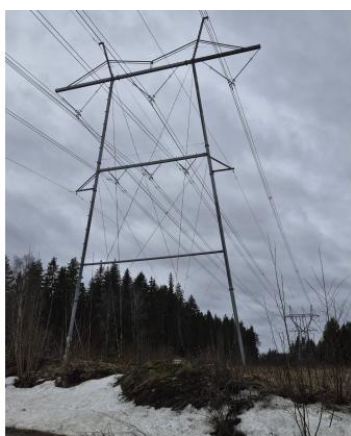
Kuva 3-3. Yhteispylvästyyppiä. Vasemmalla 400+110 kilovoltin harustettu portaalipylväs, keskellä kahden 400 kilovoltin voimajohtojen vapaasti seisova T-pylväs ja oikealla 400+110 kilovoltin vapaasti seisova Y-pylväs.
