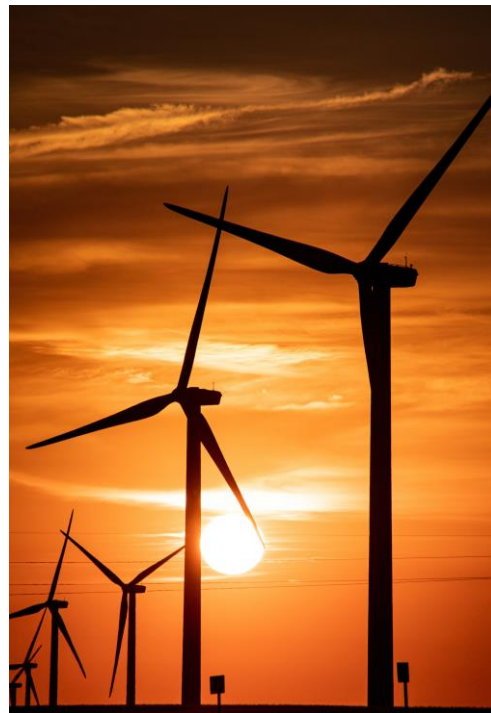
Kuva 57. Välkettä syntyy, kun voimalan lavat liikkuvat auringon paistaessa tuulivoimalan takaa. Välkevaikutukset ovat laajimmillaan aamuisin ja iltaisin, kun aurinko on matalalla.
